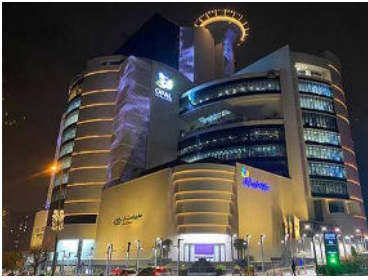
● مرکز تجاری اپال ● کارفرما: مهندس پراهام ● محل پروژه: تهران
