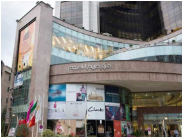
● مجتمع تجاری پلاتینیوم ● کارفرما: بست آلام ● محل پروژه: تهران
