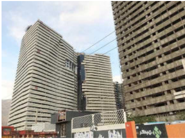
● شهرک چیتگر ● کارفرما: تعاونی مسکن فجر آفرینان غدیر ● محل پروژه: تهران - چیتگر
