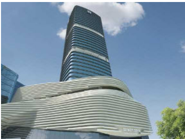
● پارسیان ● کارفرما: شرکت ساختمانی پارسیان ● محل پروژه: تهران
