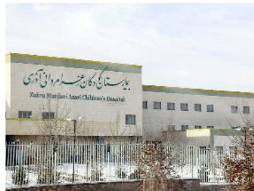
● بیمارستان کودکان زهرا مردانی آذری ● کارفرما: بنیاد خیریه زهرا مردانی ● محل پروژه: آذربایجان شرقی - تبریز
