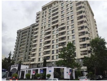
● مجتمع مروارید نیاوران ● کارفرما: شرکت ساختمانی تجارت ● محل پروژه: تهران
