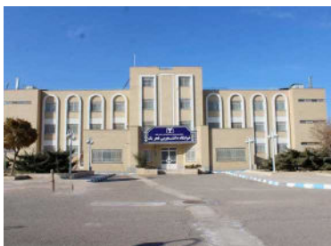
● خوابگاه دانشگاه علوم پزشکی گناباد ● کارفرما: شرکت صنعتی آموت سپهر ● محل پروژه: گناباد
