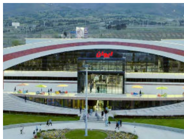
● پروژه هایپیر کالی ایوان ● محل پروژه: تهران
