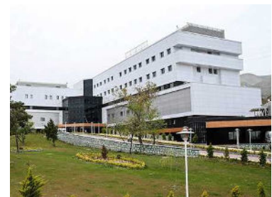
● بیمارستان قوه قضائیه ● کارفرما: شرکت دژ دیس سپاهان ● محل پروژه: تهران
