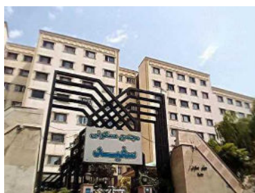
● مجتمع خانه سفید ● کارفرما: ایمن‌سازان حریق طاهها ● محل پروژه: تهران
