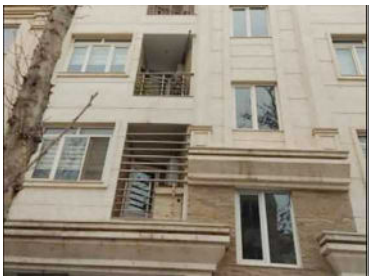
● ساختمان موسیوند ● کارفرما: آقای موسیوند ● محل پروژه: تهران
