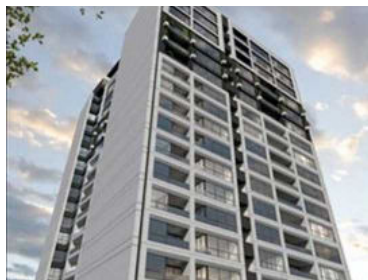
● مجتمع تندیس زنبق ● محل پروژه: تهران
